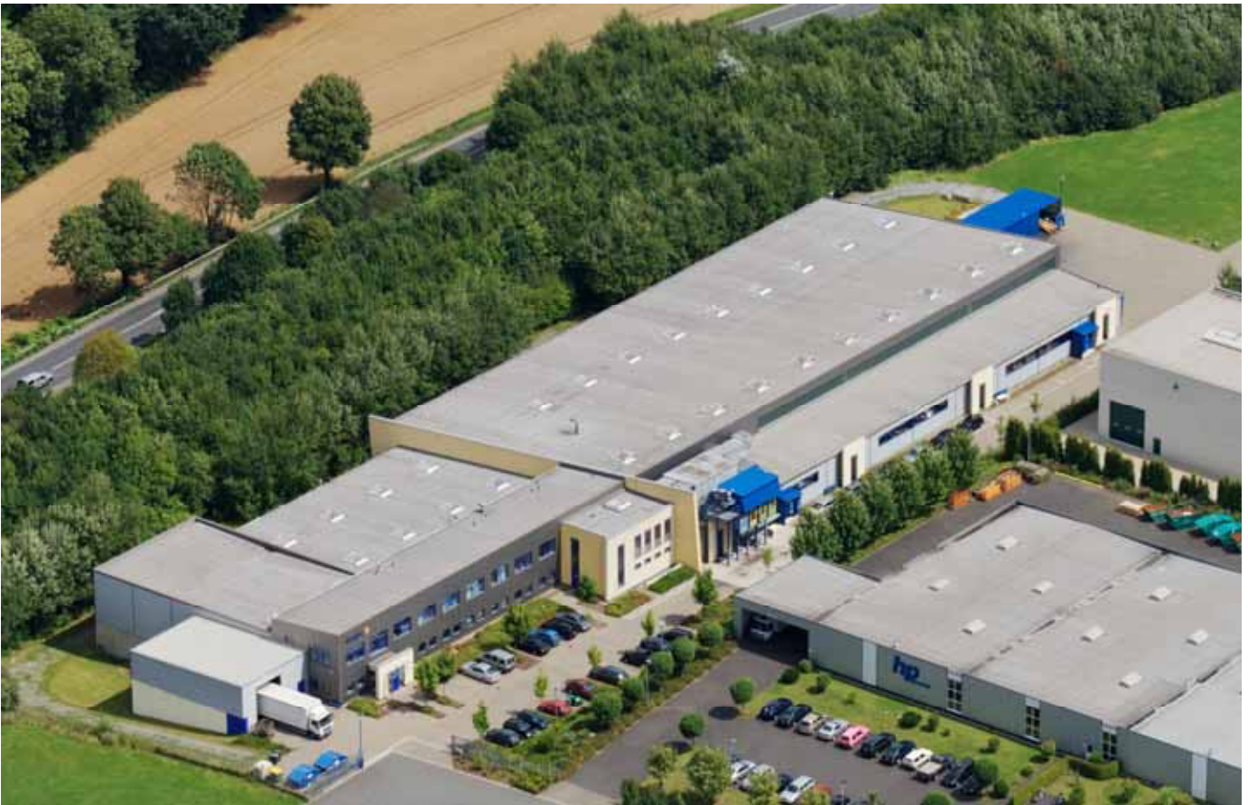
Das im September 2002 eingeweihte neue Produktions- und Verwaltungsgebäude (Foto aus Juli 2009)
